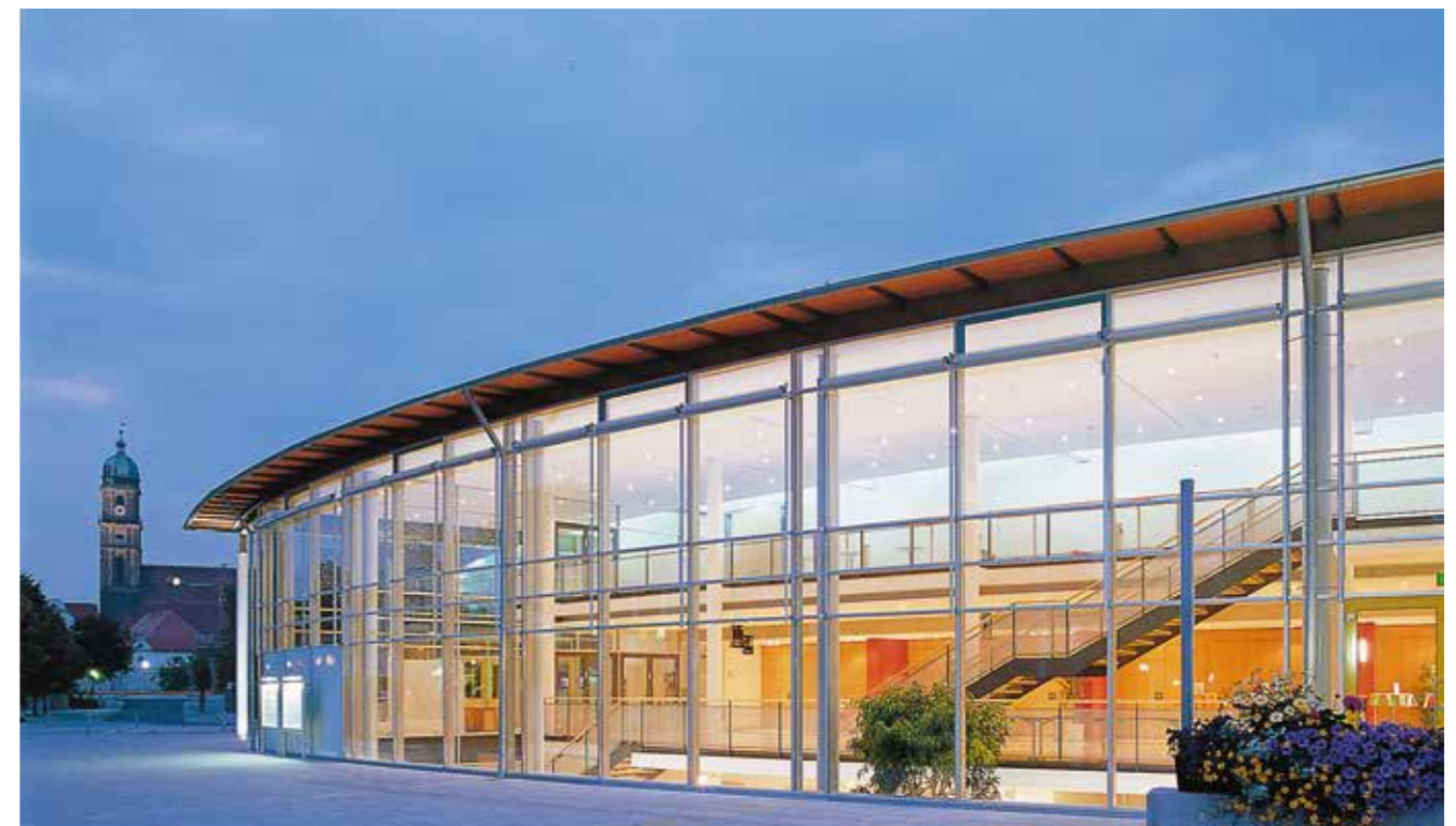
Das Amberger Congress Centrum (ACC) – gleichzeitig auch Konzertsaal – zählt zu den besten Tagungsstätten Bayerns.
