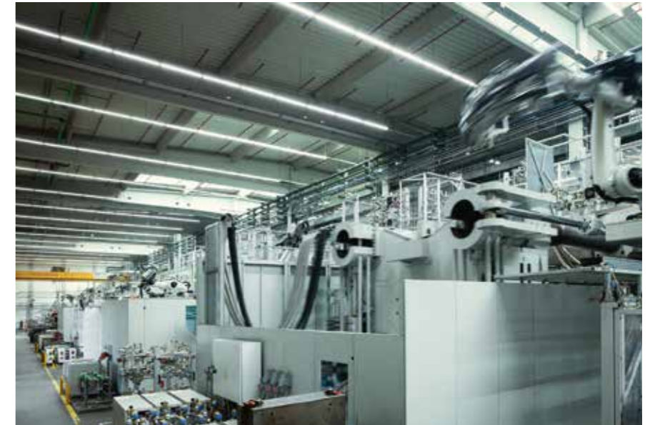
Innovative Technik und eigenes Knowhow für die Vorzüge-Lackieranlage.
