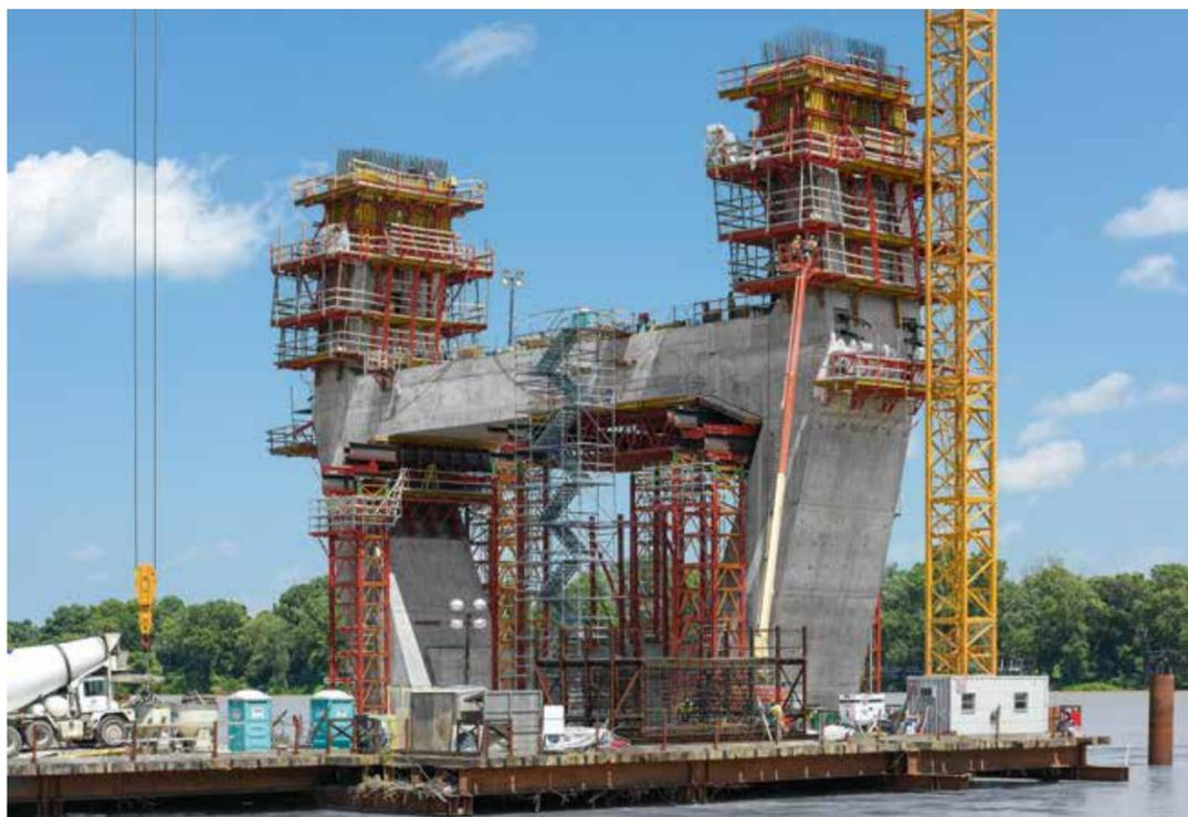
Ohio River Bridge in Louisville (USA): PERI realisierte das Schalungssystem für die 90 Meter hohen Pylone.
