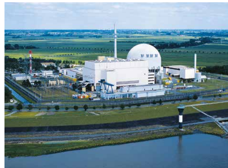
Das KKW Brokdorf (Schleswig-Holstein) gehört zu den leistungsstärksten Anlagen der Welt und wird Ende 2021 vom Netz genommen. © Preussenelektra
