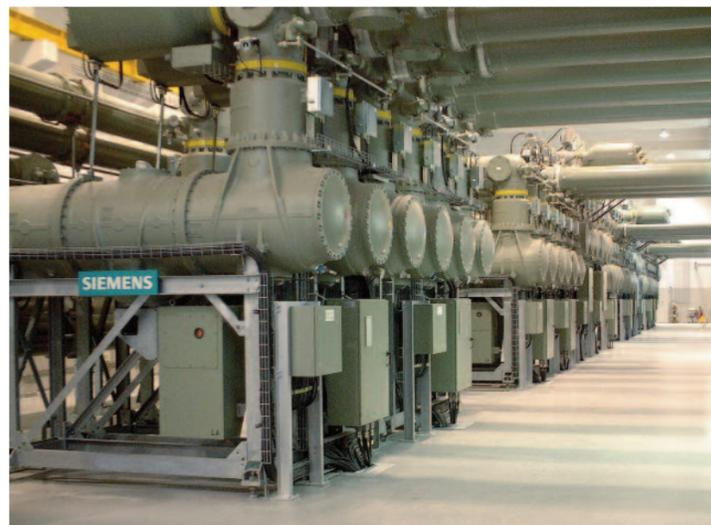
Gasisolierte Schaltanlagen (Bild) unterbrechen und schalten den Strom.
